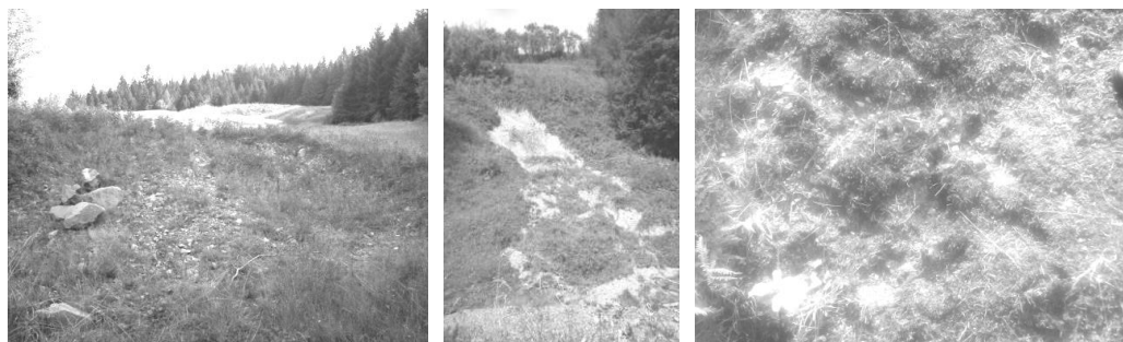
Ryc. 1. A - Powolne zsuwanie ze skarpy drobnego materiału; B - Osuwanie skarpy po opadach deszczu; C - Pełzanie gruntu i odkrywka fliszu.
